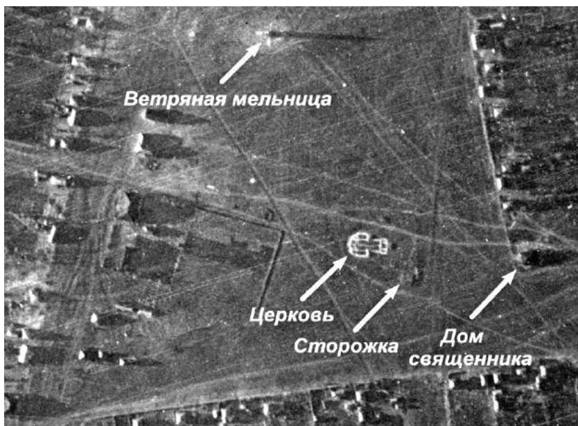
Рис. 3. Расположение церковных построек на аэрофотоснимке 1943 года 44
